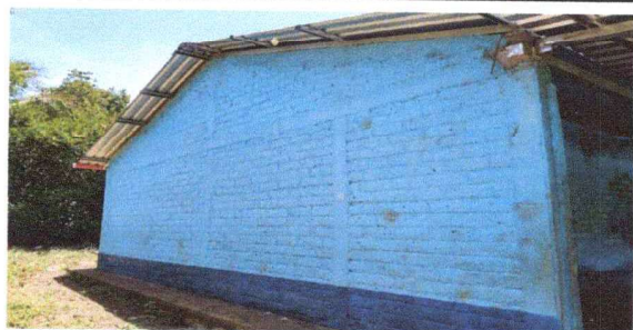
PFoto 3: FINALIZACION DE INSTALACION DE CUBIERTA DE LAMINA DE LA ESCUELA Y DEL PATIO
