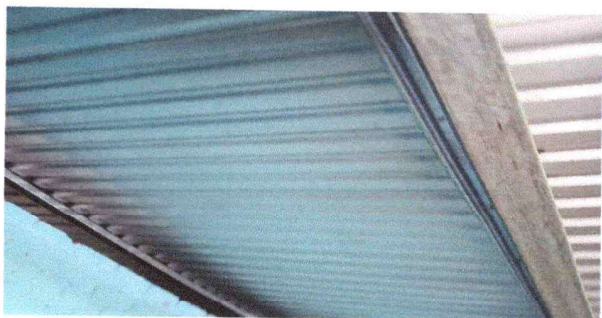
Foto1: FINALIZACION DE INSTALACION DE LAMINAS
