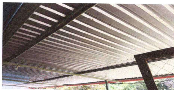
Foto 2: INSTALACION DE LAMINAS DEL PATIO
