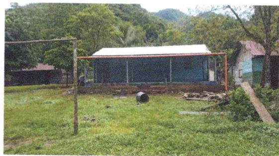
Foto 4: CANALES DE AGUAS PLUVIALES INSTALADAS
